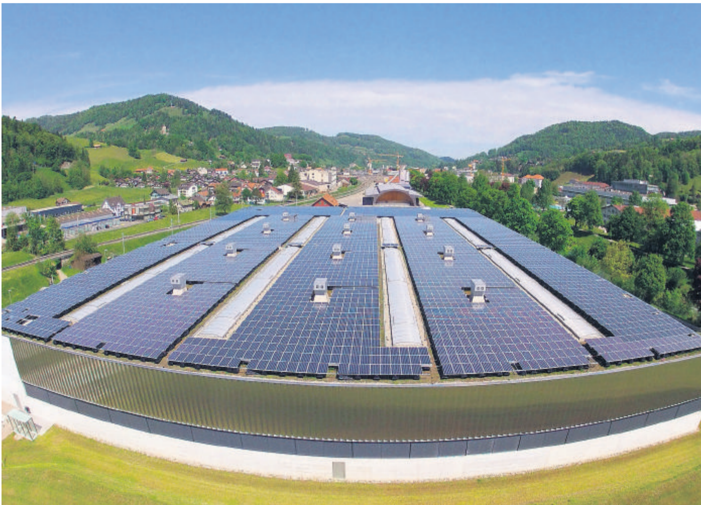
Die Photovoltaikanlage auf dem Firmengebäude der Högg AG in Wattwil ist die grösste in der Ostschweiz. Bild: pd
