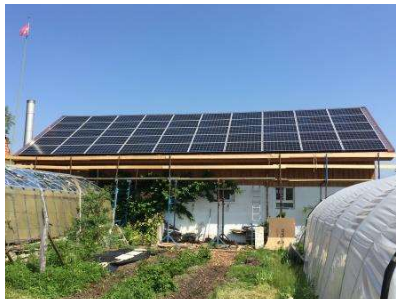
Werkstatt Bütschwil 15 kWp Indachmontage
