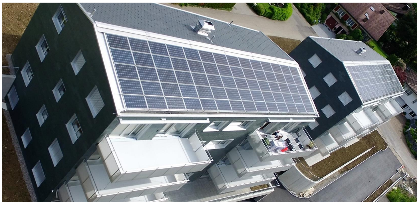
Minergie-P Mehrfamilienhäuser mit dachintegrierter Photovoltaikanlage
