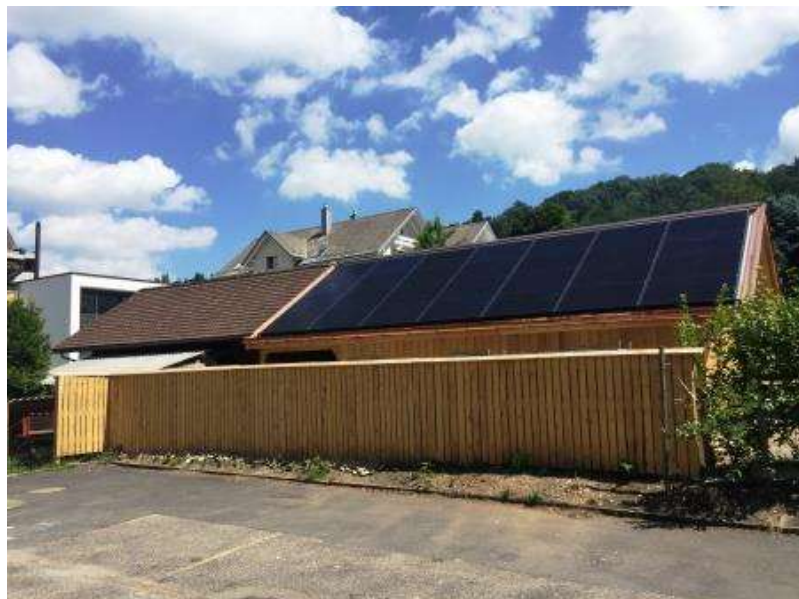
Pferdestall Ebnat-Kappel 17 kWp Indachmontage
