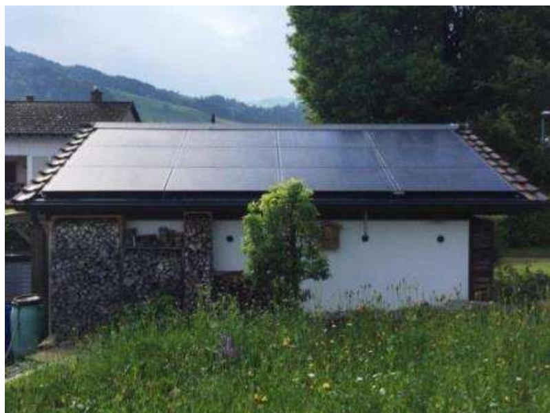
EFH Ebnat-Kappel 4 kWp Indachmontage
