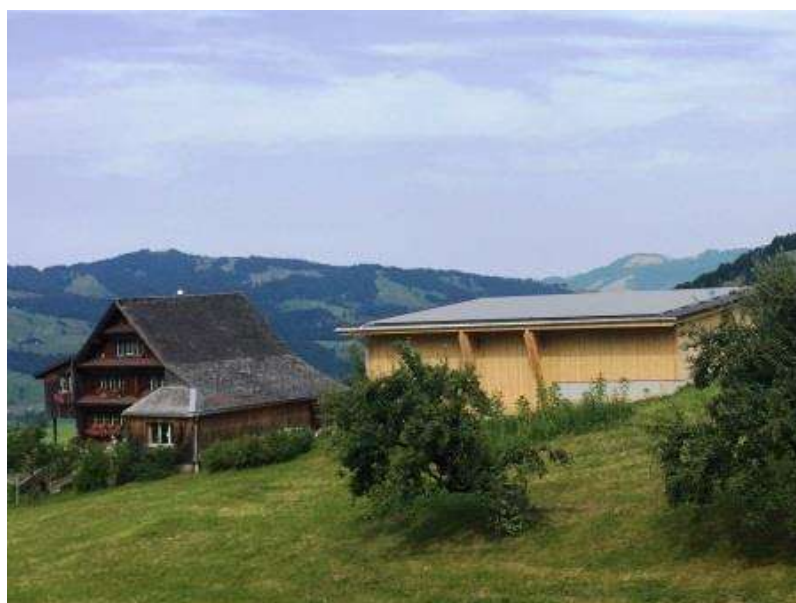
Remise Krummenau 25 kWp Aufdachmontage
