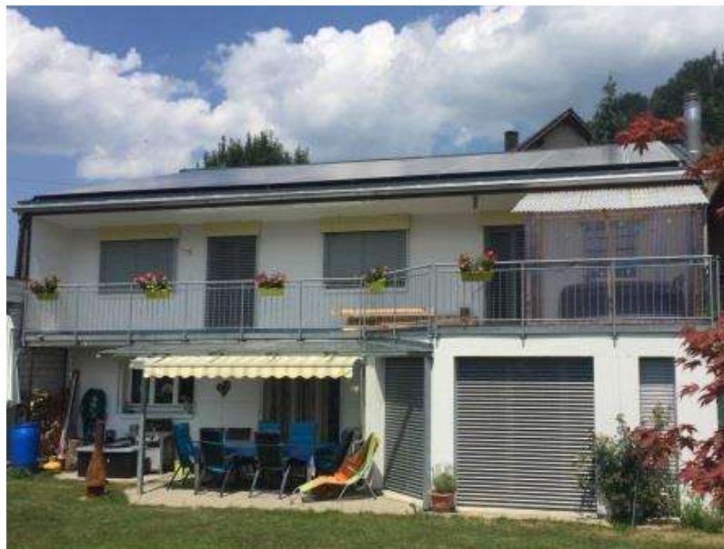
EFH Ebnat-Kappel 14 kWp Indachmontage
