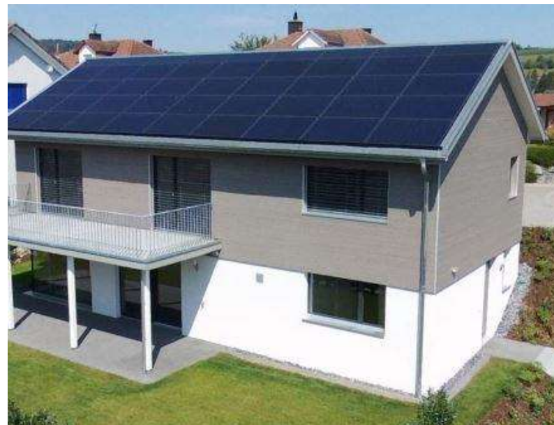
EFH Affeltrangen 12 kWp Indachmontage
